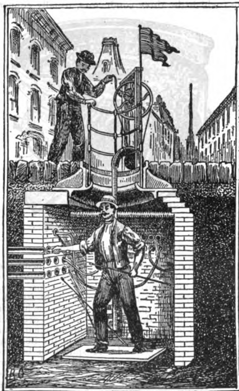
FIG. 12.—Standard Manhole.
